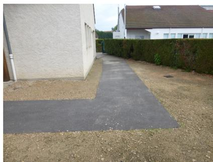
Un cheminement en enrobé a été réalisé pour contourner le bâtiment jusque dans la cour.
